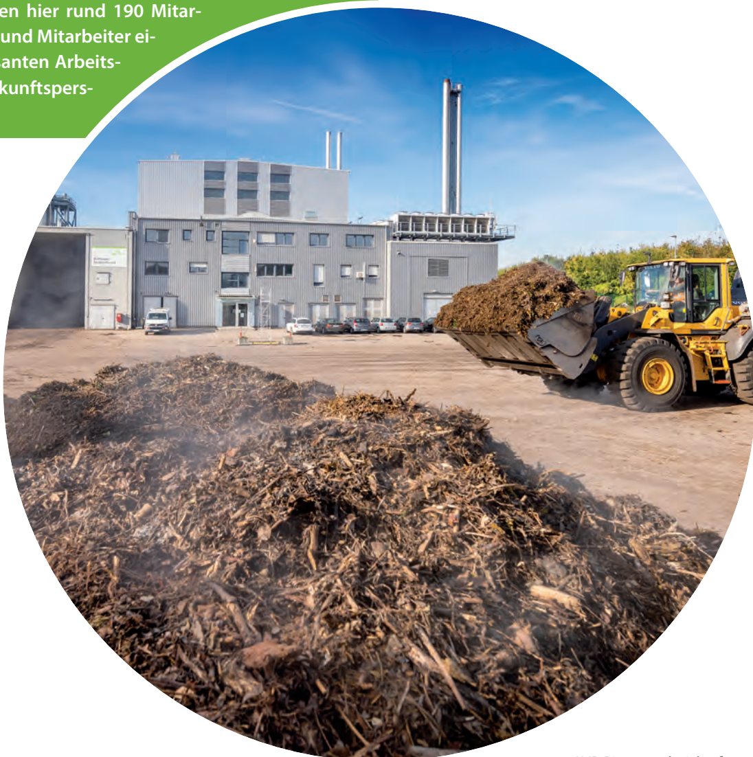
AVR Biomasseheizkraftwerk Sinsheim
